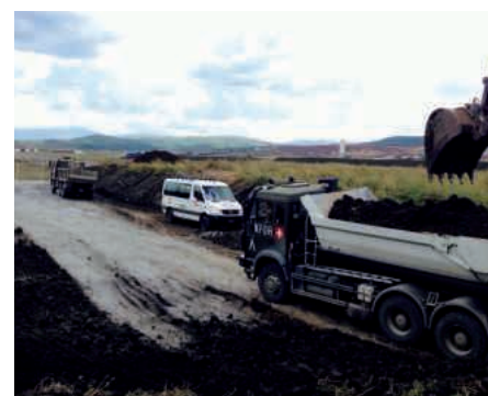
Beim Flughafen Slatina musste bei null begonnen werden, neue Wasserleitungen wurden verlegt und Stromleitungen gezogen.
