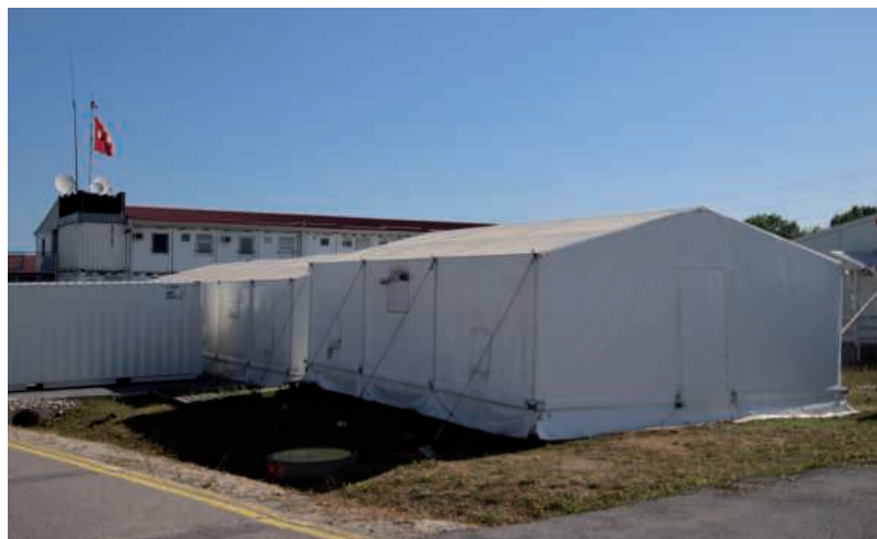
Die Zelte sind in ein bis zwei Tagen aufgebaut, haben einen festen Boden und verfügen sowohl über eine Heizung wie auch eine Klimaanlage.
