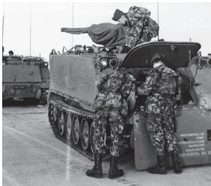
Die OS-Aspiranten 1970 bei der Ölstandskontrolle am M 113. Zum damaligen Zeitpunkt trug der Schützenpanzer noch das schwere M2-Maschinengewehr, das hier zum Transport abgedeckt ist.
