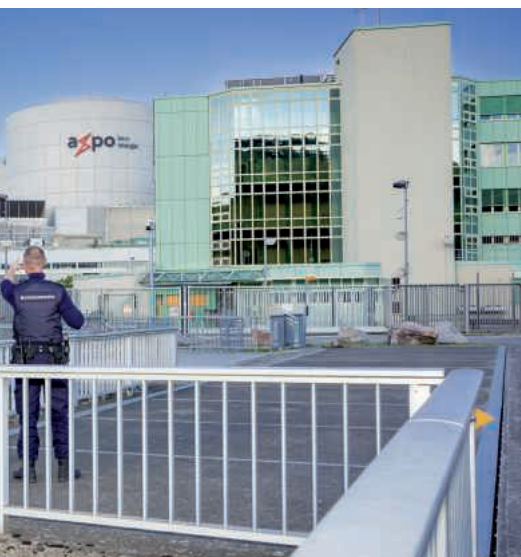
machen sich ein Bild der Anlage.
