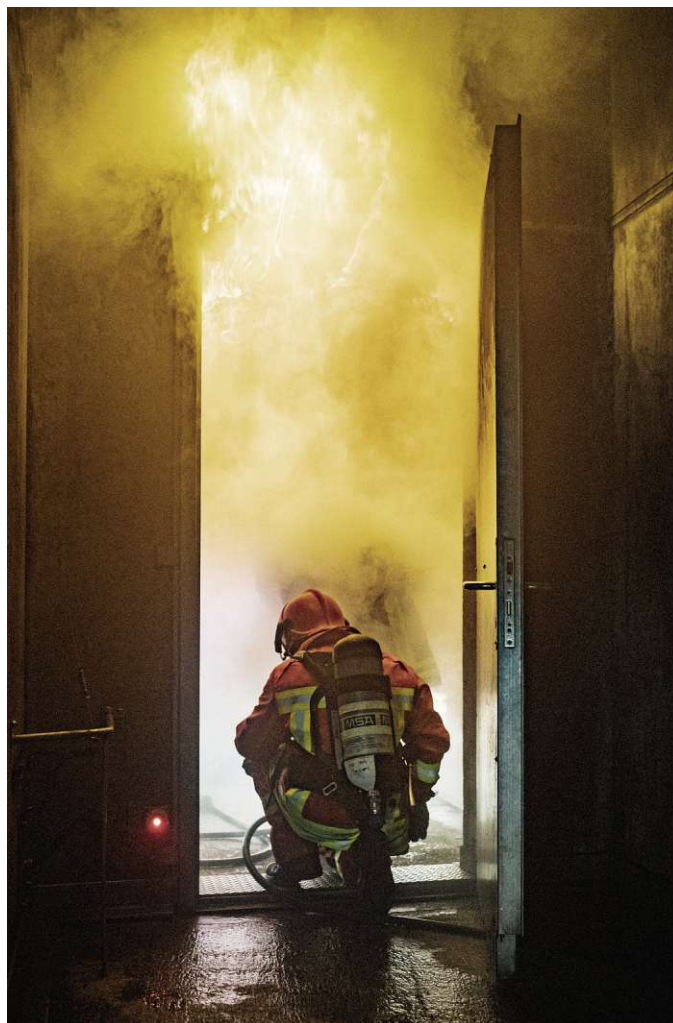
Flashover: Beim Öffnen der Türe wird durch die Sauerstoffzufuhr ein Deckenbrand entfacht.
