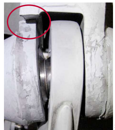
2018 wurden Risse an den Flügelklappen entdeckt.
