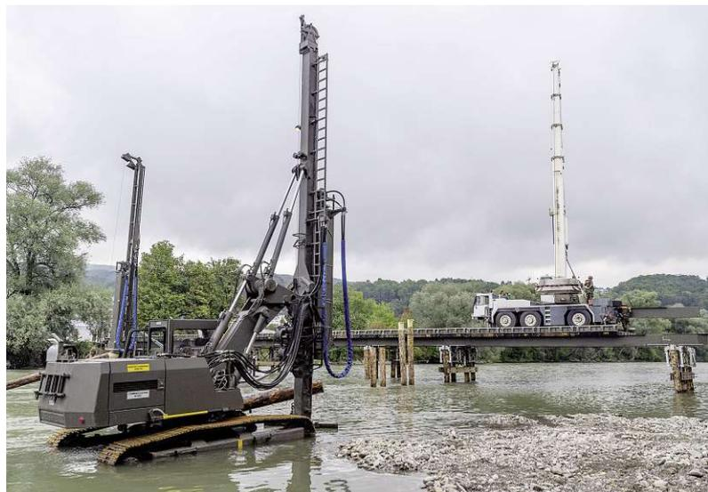
Mit Dieselramme werden die Brückenpfeiler eingesetzt.
